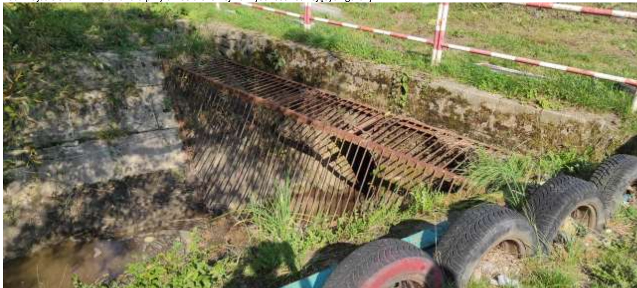
Fot.1. Ujście Skolwinki do kanału przy ul. Celulozowej na wysokości istniejących garaży
