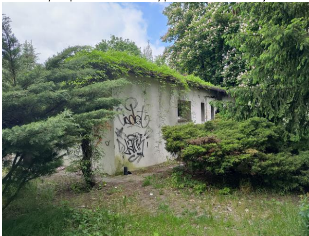
Fot. 5. Budynek przedszkola od strony południowo-wschodniej
