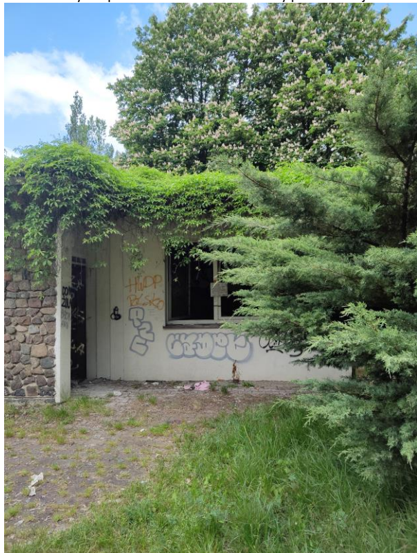
Fot. 14. Budynek przedszkola – widok od strony południowej
