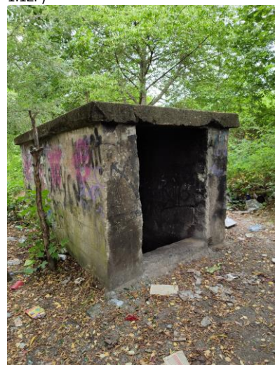
Fot. 9. Wejście do schronu (teren elementarny 1.1ZP)
