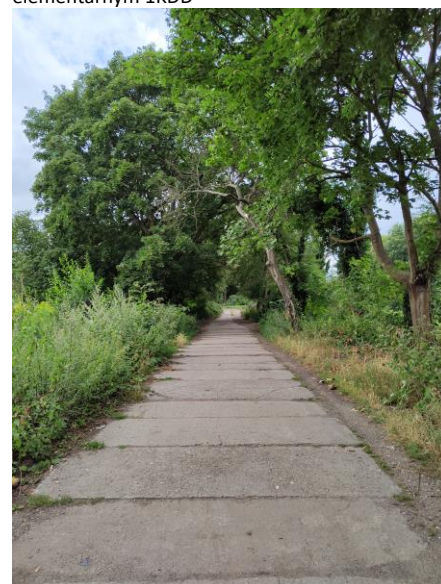
Fot. 3. Zieleń nieurządzona w terenie elementarnym 1KDD
